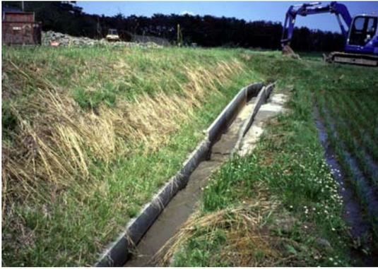
写真 2.8 液状化して浮上した側溝
