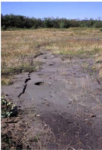
写真 2. 30 十勝川右岸堤外地の液状化
