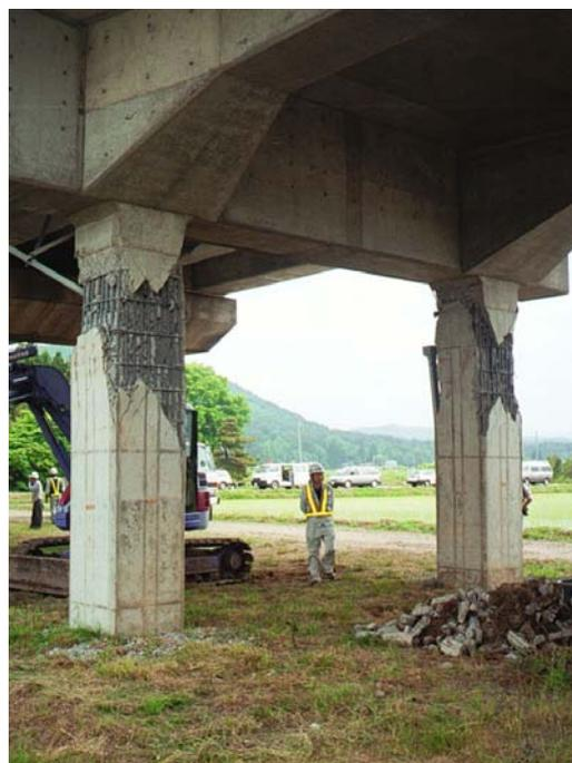
写真 2.1 東北新幹線高架橋の被害状況
