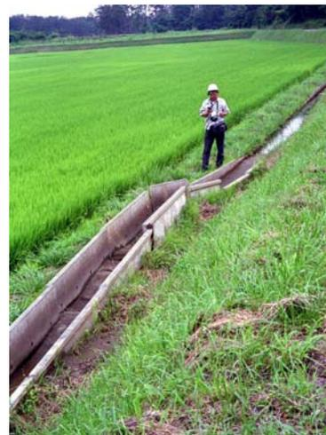
写真 2.25 再液状化して浮き沈みが拡大
