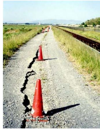
写真 2.11 段差が生じた農道
