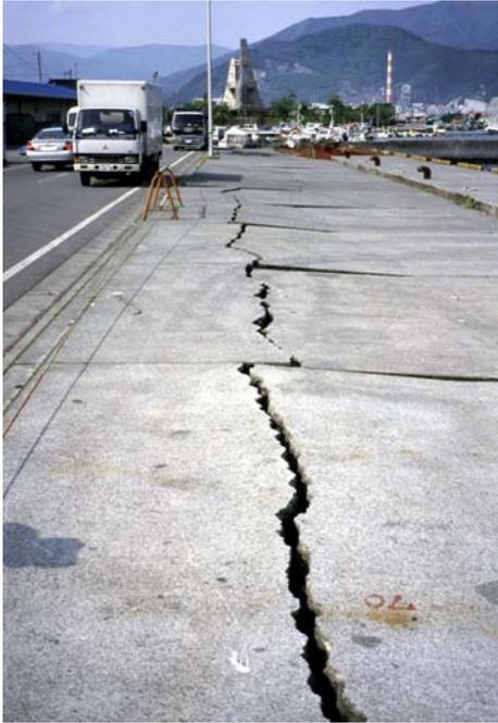
写真 2.4 岩手県大船渡魚港の岸壁背後地盤の沈下と舗装面のクラック
