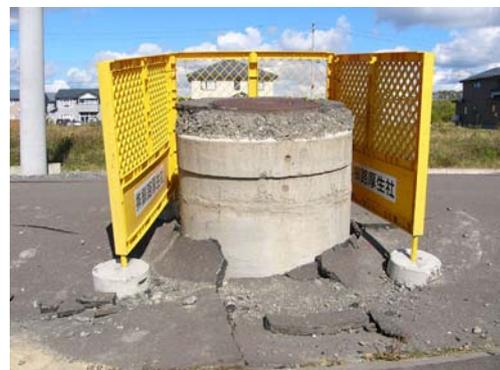
写真 2. 34 釧路町東陽団地における液状化によるマンホールの浮上
