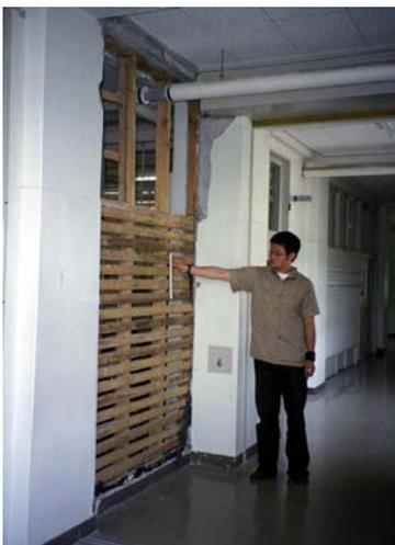
写真 2.12 岩手県大船渡高校における壁の崩壊 (5月28日)
