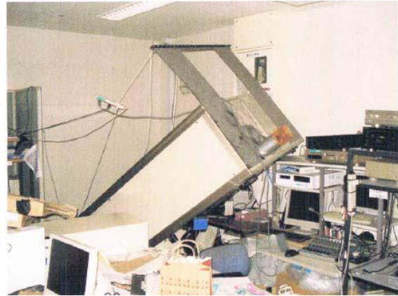
写真1 fmいずみ内の被害状況（マスターが倒れた） 写真は阿部氏提供
