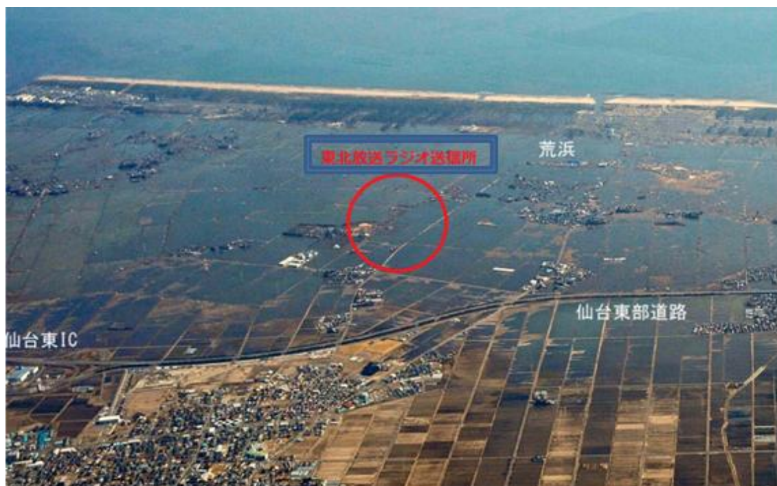
写真-1 仙台市若林区にある東北放送ラジオ送信所の津波被災状況(3 月 13 日アジア航測(株)撮影)
