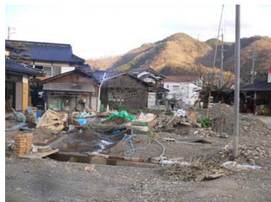
図-13 佐用川越水破堤点の堤内(久崎地区)
