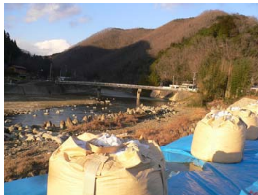
図-12 佐用川越水破堤点の堤外(久崎地区)
