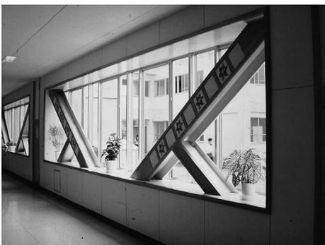
図-4 学校校舎の耐震補強（静岡県立清水南高等学校）
